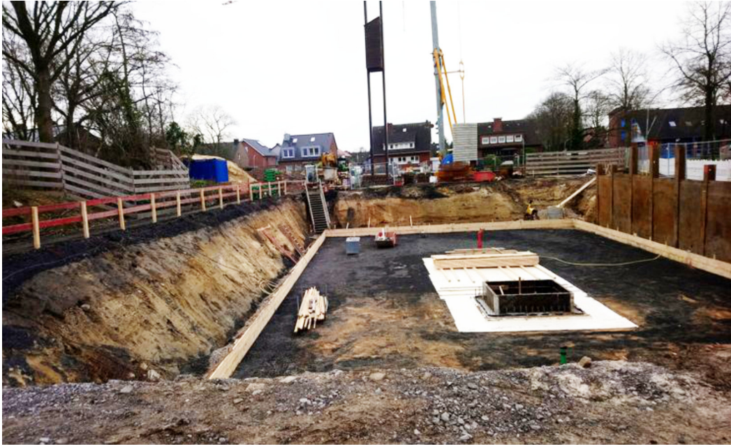
Deutlich sichtbar auf unserem Grundstück in Nienberge die Baugrube und erste Fundamente für Haus I, in dem unsere kirchlichen Räume enthalten sein werden (Stand 12.02.2023). Foto: Anne Demtröder
